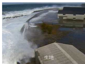
高波の越波状況（黒部市生地地区）
