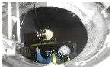
水位計を下水道管内等に設置
