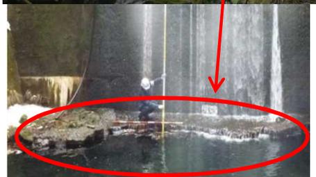
不具合の程度が進行すると、**転倒や大きな破壊**に繋がり、砂防堰堤の持つ機能を発揮できなくなるため
