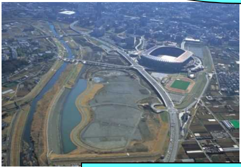
洪水調節施設
