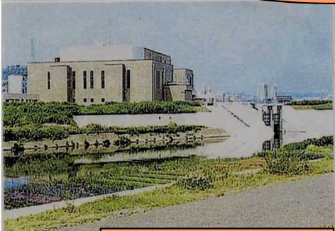
内水排除施設
