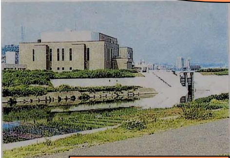
内水排除施設
