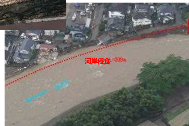
河岸侵食に伴う家屋倒壊等
