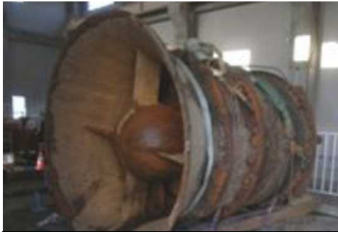
毛無排水機場ポンプ更新
