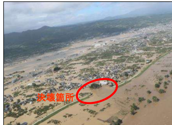
浸水状況(10月13日12時) 59
