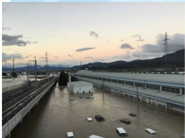
北陸新幹線 長野新幹線車両センター浸水
