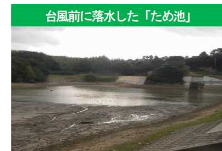
(H26.10 淡路市志筑 黒田池)
