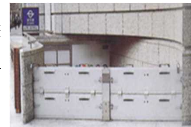
浸水対策の例： 止水板（脱着式）の設置
