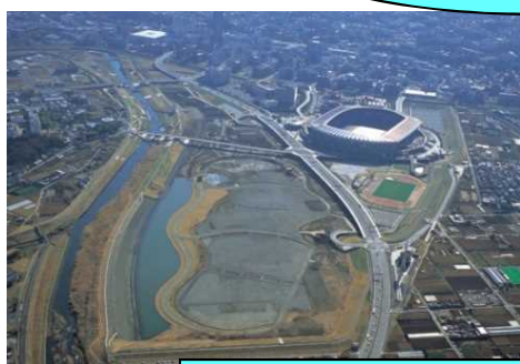
洪水調節施設
