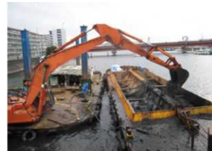
河川対策(鶴見川下流部河道掘削状況)
