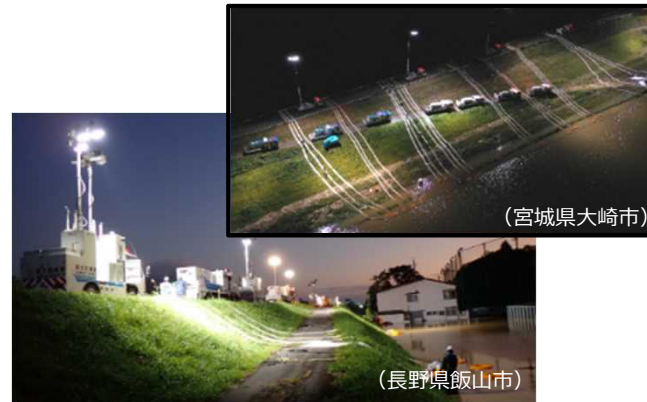
排水ポンプ車による24時間体制の緊急排水状況 (宮城県大崎市)
