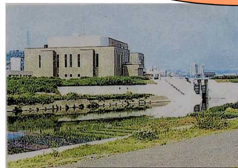
内水排除施設
