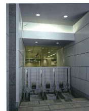
ビルの出入口の止水板
