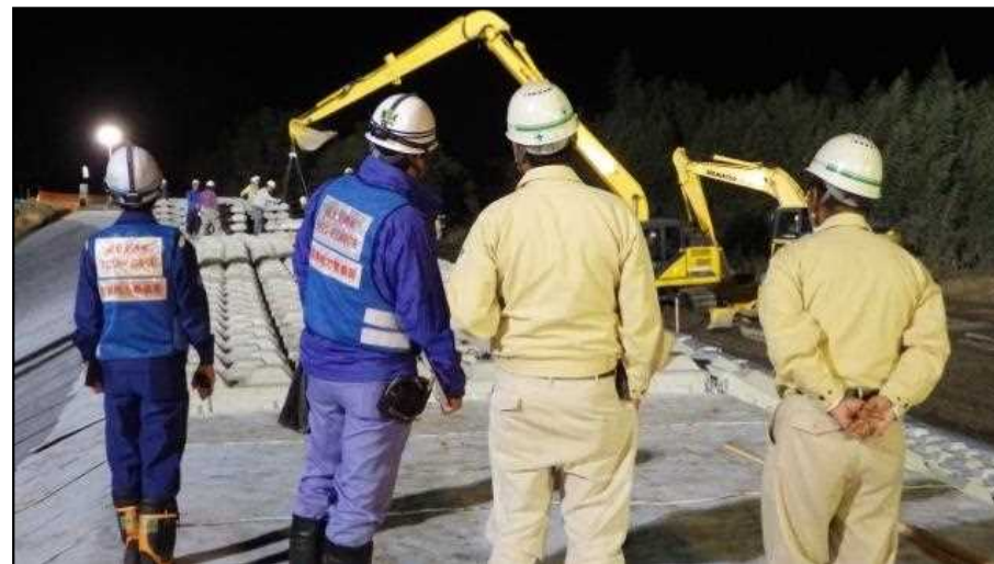
協力企業と連携した堤防の復旧工事(埼玉県東松山市)
