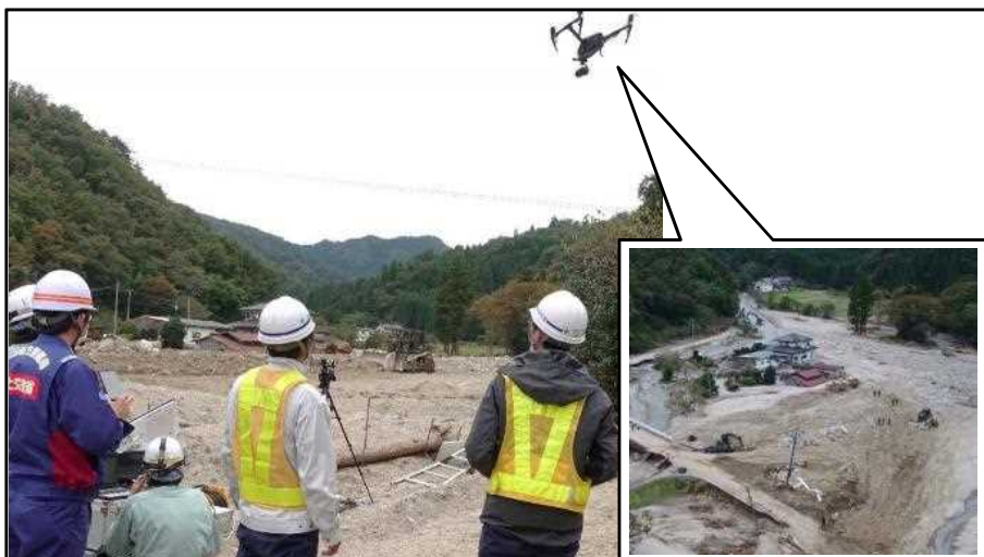
協力企業と連携したドローンによる被災箇所調査(宮城県丸森町)
