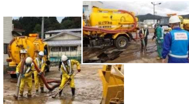
協力企業と一体となった堆積土砂の撤去 (長野県長野市)
