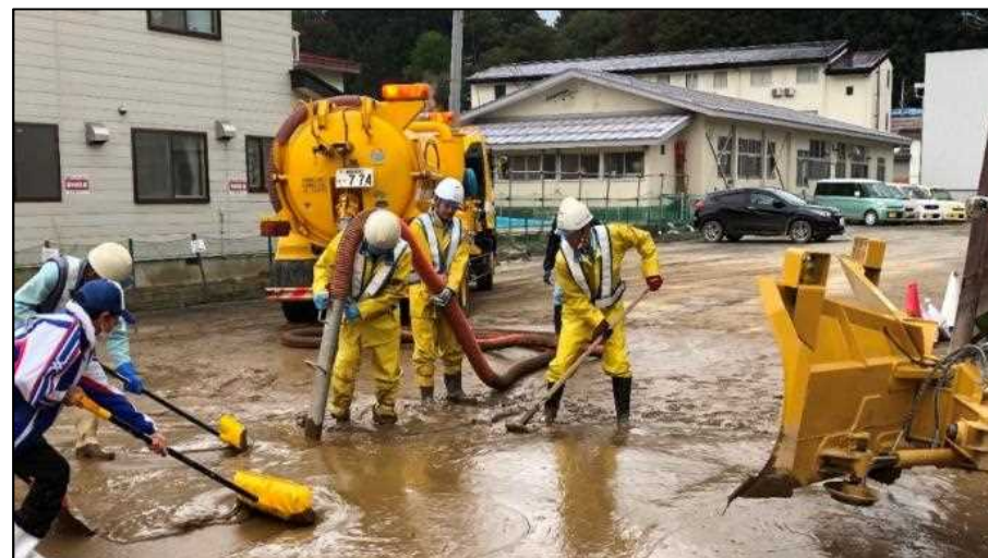
協力企業と連携した堆積土砂の撤去作業(長野県飯山市)
