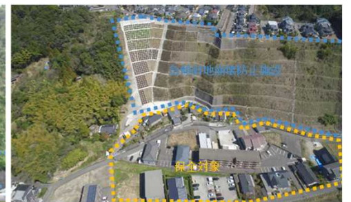
急傾斜地崩壊防止施設 (鹿児島市市田上)
