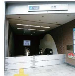
出入口の止水板
