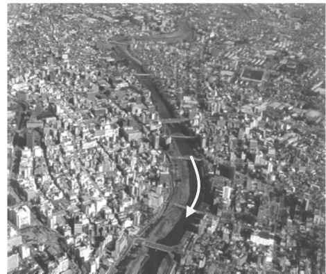
市街地部を貫流する白川（熊本県）
