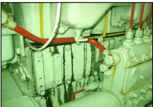
ポンプ原動機からのオイル漏れ
