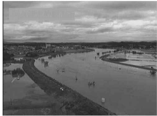
阿武隈川阿久津地点の出水状況
