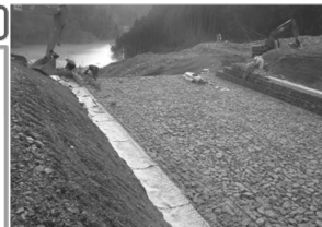
仮排水路施工状況 (奈良県十津川村長殿)
