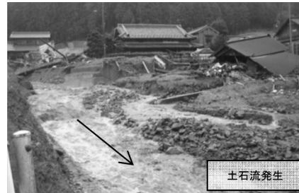
三重県津市 所谷川
