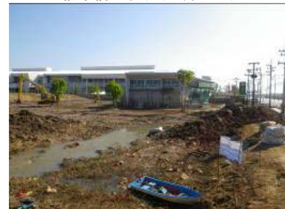
排水後の状況(11月27日)
