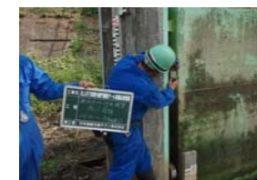
ゲート設備の点検・整備
