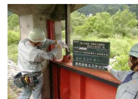
樋管ゲートの点検
