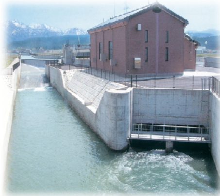
七ヶ用水発電所(手取川水系手取川) (従属発電)
