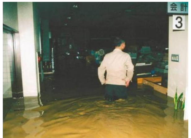
平成 16 年台風 23 号により浸水した 大江町役場 19)
