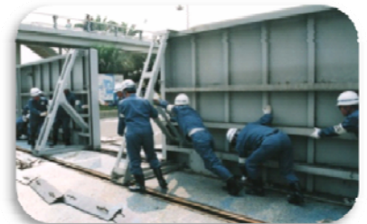
(陸閘の閉鎖作業)
