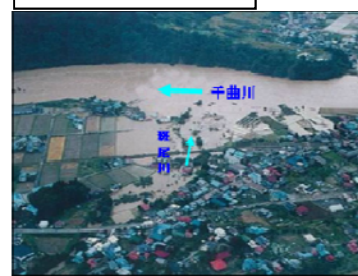
中野市替佐地区の浸水状況
