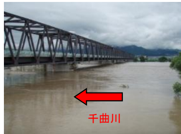
H18年7月洪水により水位が上昇した村山橋No. 60k付近（長野市）
