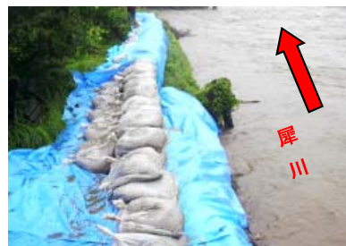
H18年7月出水時における犀川の 水防工法実施状況（安曇野市）
