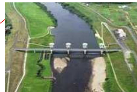
鳴瀬川中流堰(H13完成)
