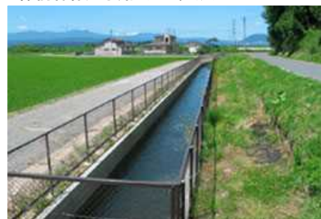
館前幹線用水路 (H16完成)
