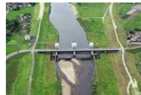
桑折江堰(H15完成)
