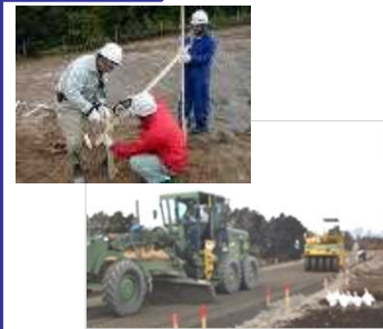
従来施工(丁張りによる施工)
