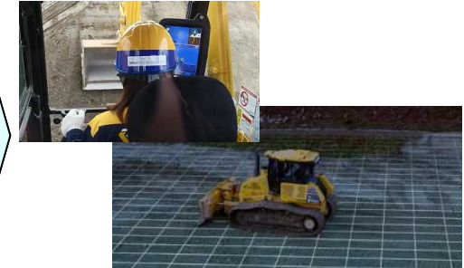
ICT建機による施工
