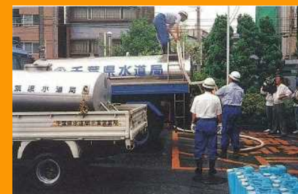
応急給水に備え給水車を待機
