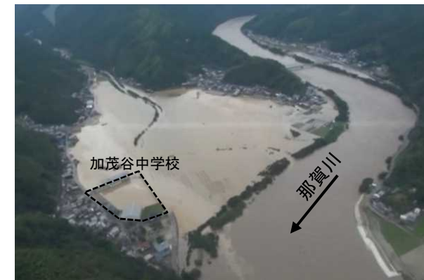
平成26年8月台風11号の影響による浸水状況
