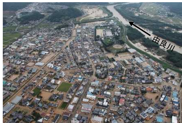
平成26年8月豪雨による浸水状況
