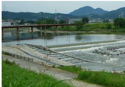
魚道整備による魚類の遡上・降下環境の改善
