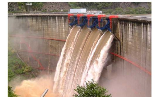
矢作ダム非常用洪水吐きからの放流
