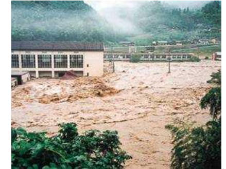
流失した幼稚園（豊田市（旧旭町））
