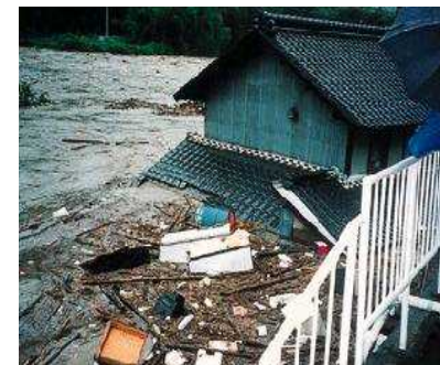
浸水した家屋（豊田市 藤沢町）
