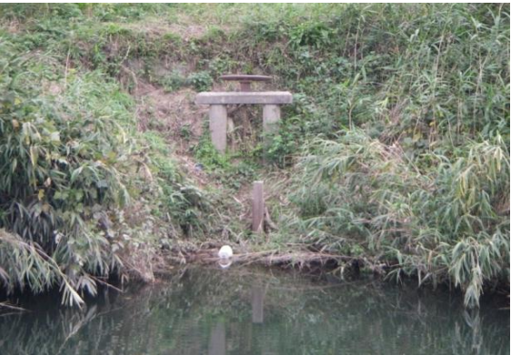
写真 1-21 樋管の状況、樋管函体からの漏水
