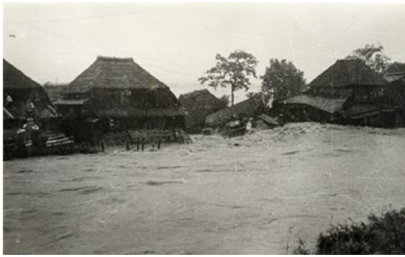
写真 1-5 昭和 28 年 6 月洪水 城原川沿岸の民家流出
