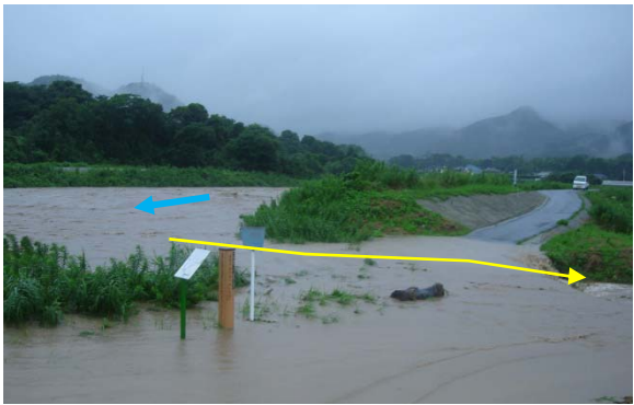
写真 1-10 平成 22 年 7 月洪水 4 号野越しからの越水状況
