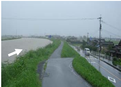
写真 1-17 平成 22 年 7 月洪水 (新村橋付近)
