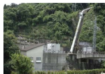
写真 1-12 広滝第二発電所
