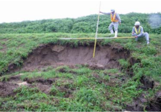
写真 1-20 平成 21 年 7 月洪水による堤防川裏法面の崩壊 (L=80m)、堤防川裏法尻からの漏水
