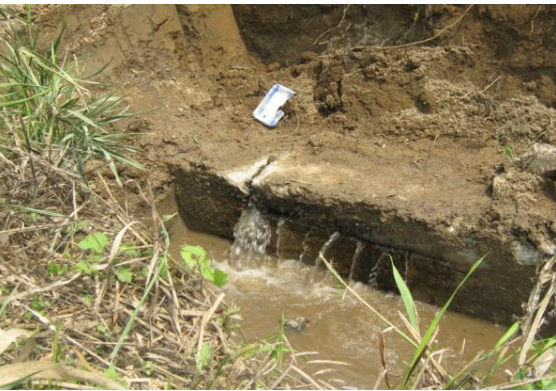
写真 1-21 樋管の状況、樋管函体からの漏水
