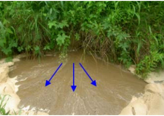
写真 1-20 平成 21 年 7 月洪水による堤防川裏法面の崩壊 (L=80m)、堤防川裏法尻からの漏水
