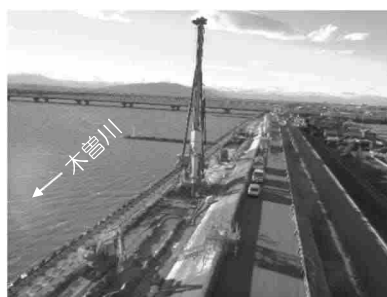
河川堤防における地震・津波対策 （三重県木曽岬町）
