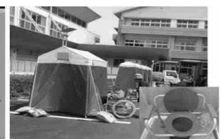
マンホールトイレの設置例 （熊本市）
