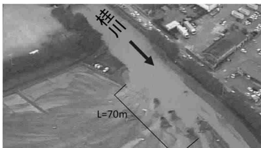
堤防決壊（桂川右岸） 福岡県朝倉市
