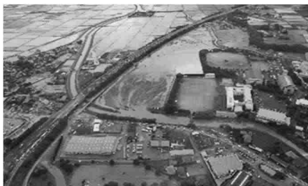
桂川沿川の浸水被害（福岡県朝倉市）
