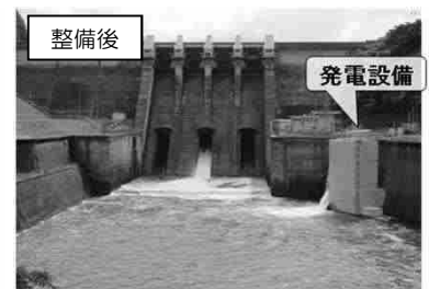
ダム管理用発電設備の設置例
