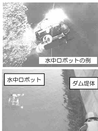
水中ロボットによる点検状況
