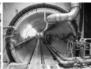
雨水貯留管の整備
