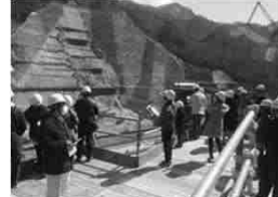
建設中ダムの現場見学 ハッ場ダム(群馬県)
