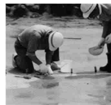
クラック補修状況（注入工）
