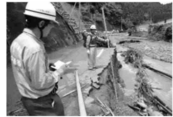
県道 509 号の被害状況調査
