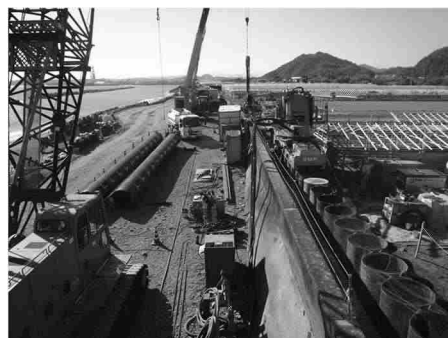
海岸堤防の耐震対策（高知県南国市）
