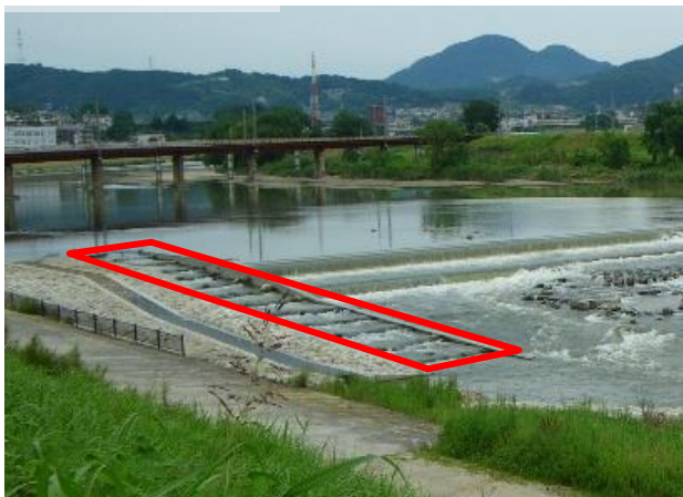
魚道整備による魚類の遡上・降下環境の改善
