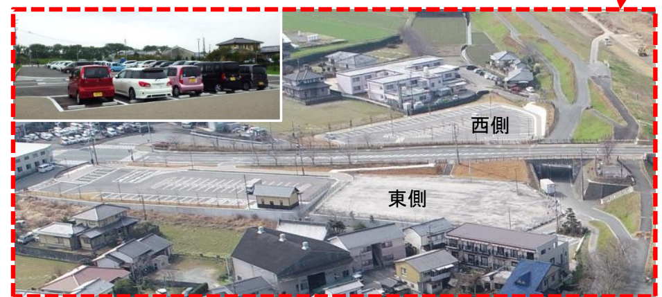
▲県営「筑後広域公園」(サブエントランス)
