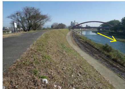
船小屋地区右岸側 （川表堤防の状況）
