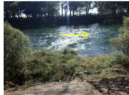
船小屋地区右岸側 （水際の状況）
