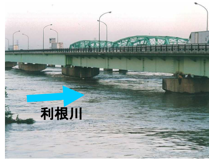
出水状況 利根川橋(国道4号) 埼玉県久喜市(旧栗橋町)
