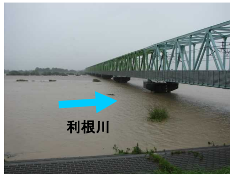
出水状況 利根川橋梁(東北本線) 埼玉県久喜市(旧栗橋町)
