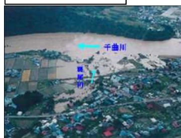
中野市替佐地区の浸水状況
