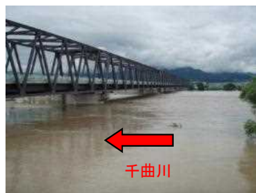
H18年7月洪水により水位が上昇した村山橋No. 60k付近（長野市）
