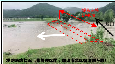
被災状況(平成30年7月豪雨)
