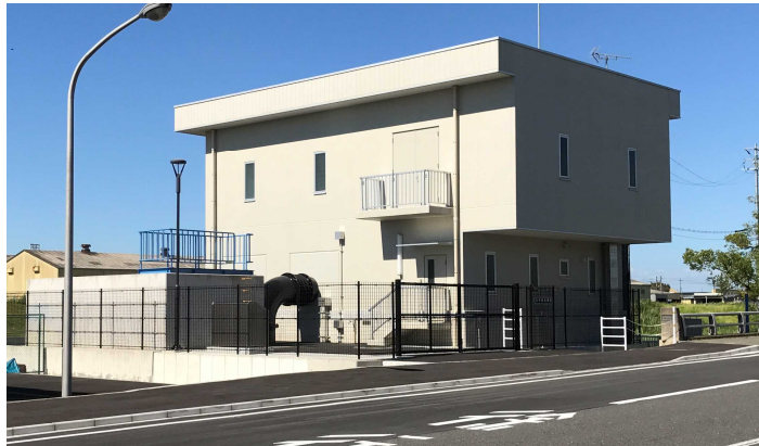
◆大垣市による排水機場整備 (大井排水機場)
