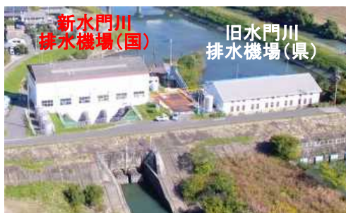
写真 新・旧水門川排水機場の全体状況
