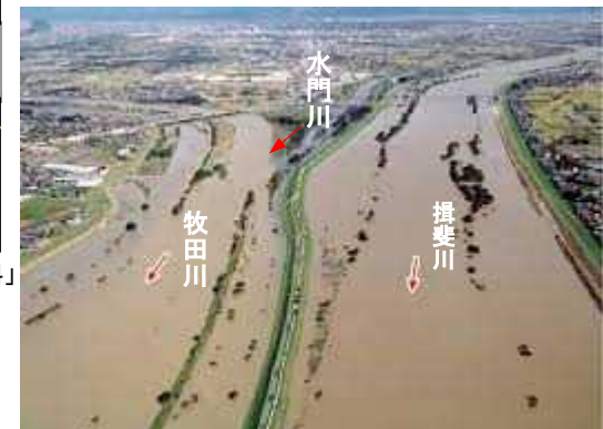
◆牧田川、杭瀬川、水門川、揖斐川の出水状況 (平成16年10月洪水)
