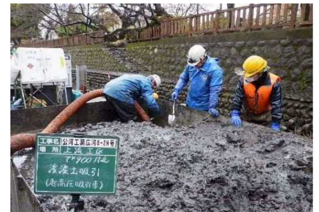
◆水門川河床掘削状況(県)
