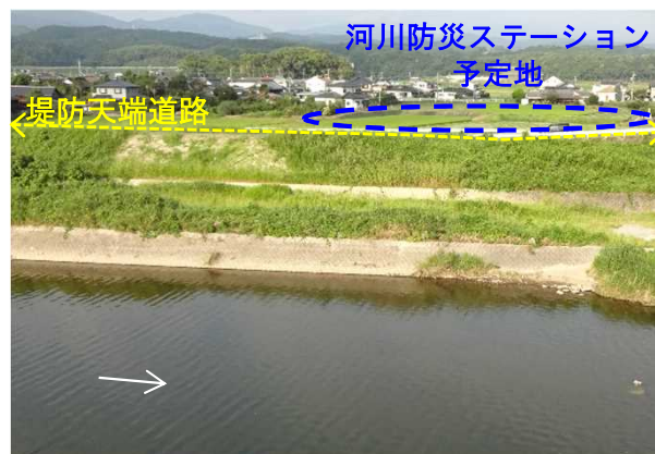
① 堤防から川側へ降りるアクセス路がない
