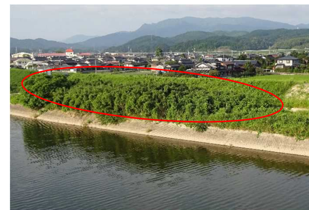
② 樹木が繁茂し、水辺へ安全に近づけない
