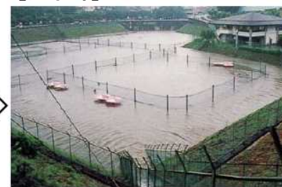
雨水貯留浸透施設の例(防災調整池)
