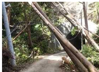
⑧ 電柱・倒木倒壊の状況 (千葉県鴨川市)
