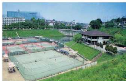
雨水貯留浸透施設の例(防災調整池)
