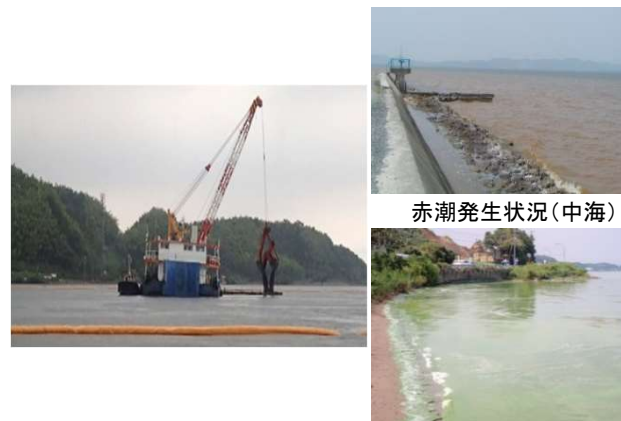
覆砂等による水質の浄化(中海、宍道湖)
