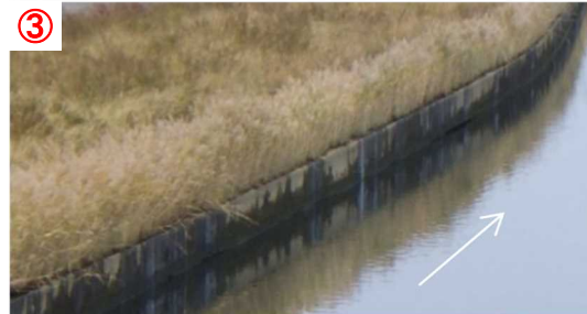
護岸は垂直な形状で、 水辺へ安全にアクセスできない
