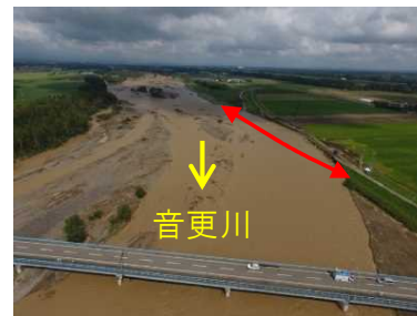
平成28年8月洪水 音和橋付近の決壊後の状況 （音更町）
