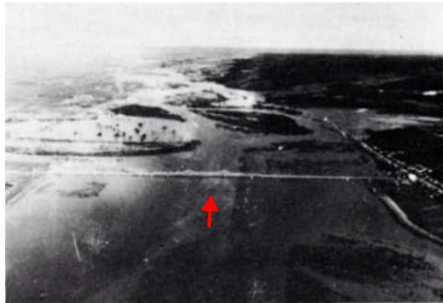
昭和37年8月洪水 十勝川茂岩橋付近のはん濫状況 （豊頃町）
