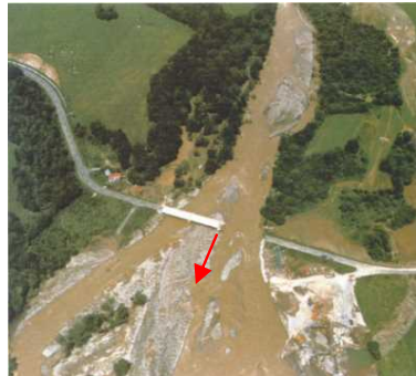
昭和56年8月洪水 然別川 西瓜幕橋付近の 被災状況（鹿追町）
