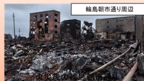
火災後の市街地状況 （輪島市）
