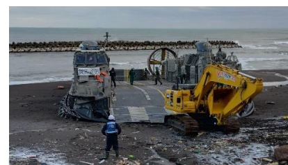
▲自衛隊LCACから陸揚げされる緊急復旧用バックホウ
