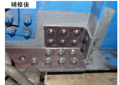
あて板による鋼部材の補修
