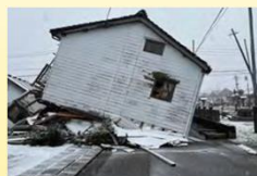
木造住宅の被害
