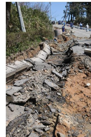
水道水を配水する拠点となる配水池に送る送水管の被災（輪島市送水管）
