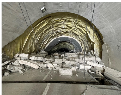
国道249号大谷トンネル（珠州市）
