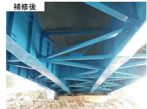
錆の除去と塗装の塗替えによる補修
