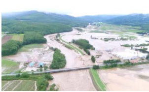
空知川の堤防決壊による浸水被害 (北海道南富良野町)
