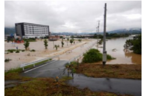
肱川における浸水被害 (愛媛県大洲市)
