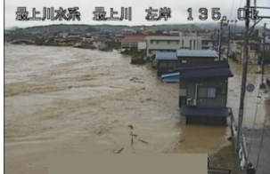
最上川における浸水被害 (山形県大江町)
