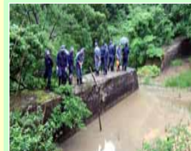
砂防設備の点検状況
