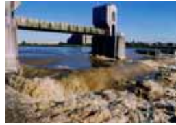
遠隔操作システムによる操作
