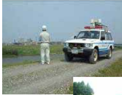
パトロールカーによる巡視
