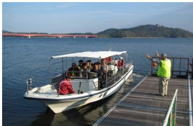
◇ 船舶係留施設
