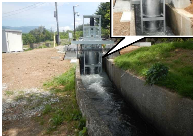
発電所設置後の現況 ▶
