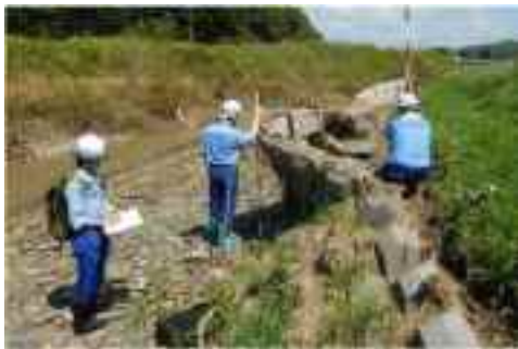
TEC-FORCEによる被災状況調査
