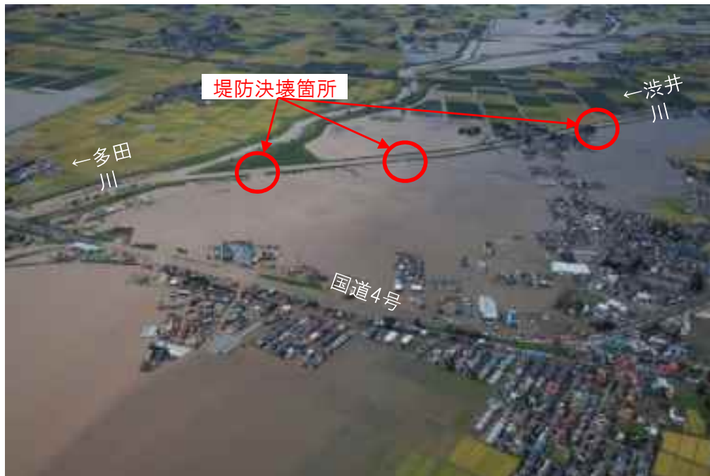
浸水状況（大崎市）
