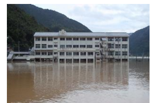
H26.8避難所2階の浸水 (徳島県)
