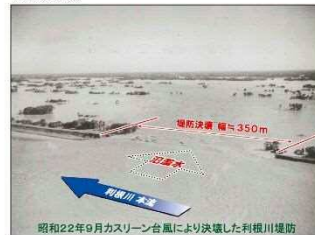
昭和22年9月カスリーン台風により決壊した利根川堤防
