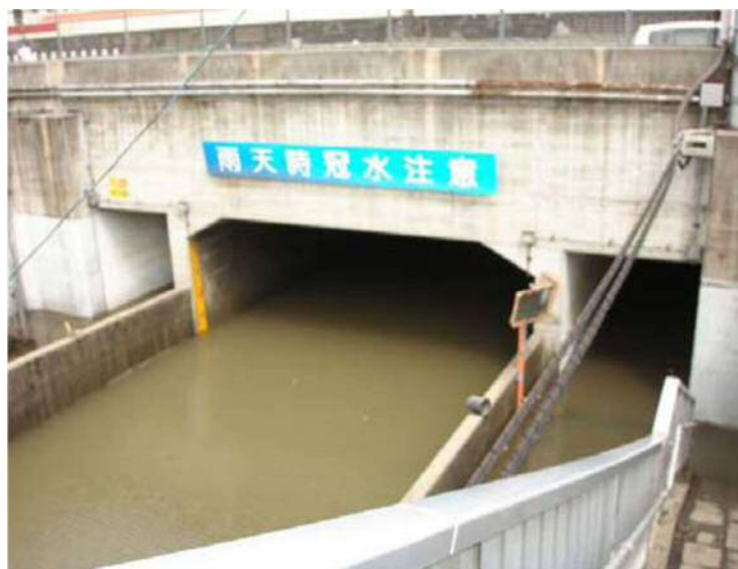
図 2-9 アンダーパス冠水の事例（埼玉県幸手市）
