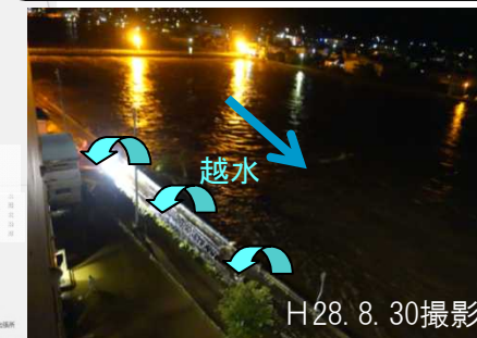
久慈川(右岸)越水状況
