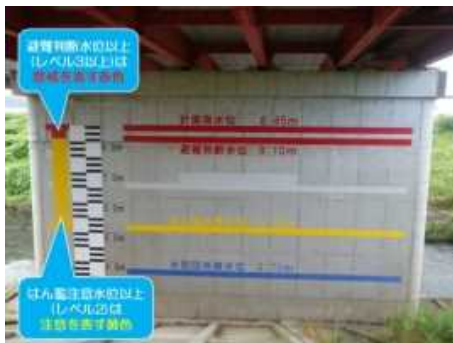
橋脚に水位表示
