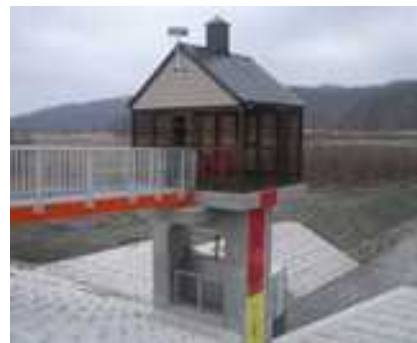
樋管に水位表示
