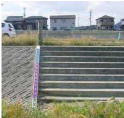
階段に水位表示
