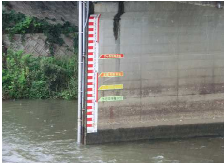
水位標設置状況
