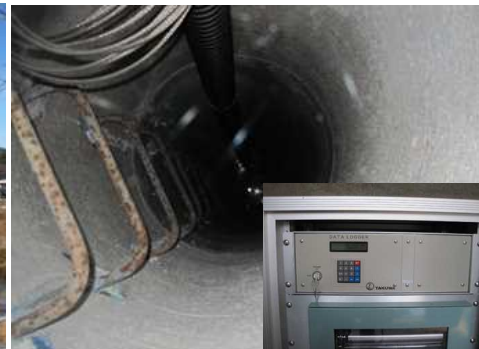
水位計設置状況
