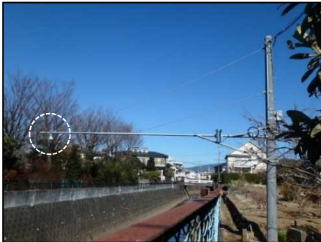
水位計設置状況
