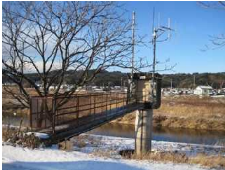
水位観測所設置状況
