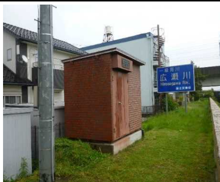
観測局舎設置状況
