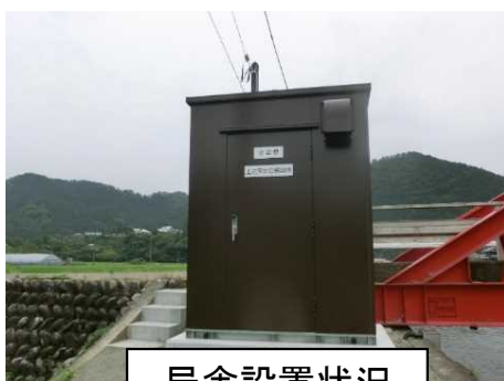
局舎設置状況
