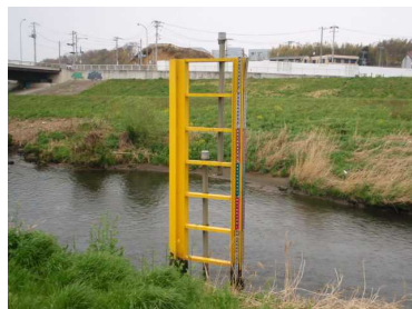
水位計・水位標設置状況(副)
