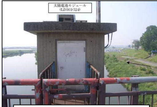
局舎設置状況
