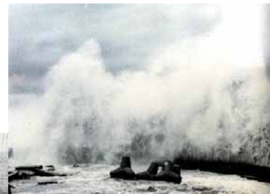
越波状況(入善町八幡地先) やはた
