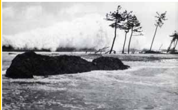
越波状況(入善町神子沢地先) みこさわ
