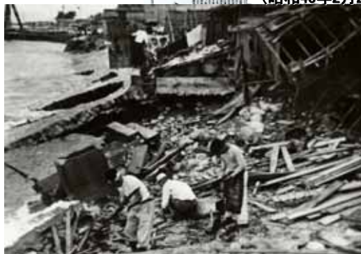
被災の状況(黒部市生地地先)
