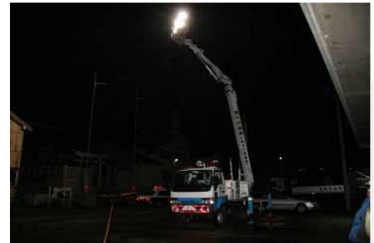
照明車支援状況(入善町芦崎地先)
