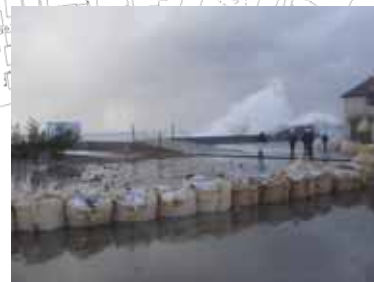
大型土のう設置状況(黒部市生地)
