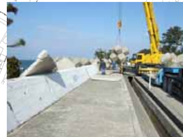
異形ブロック設置状況(入善町芦崎) (ブロックを貸与)
