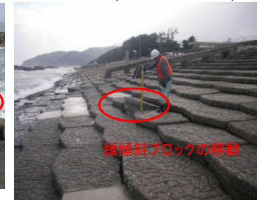
緩傾斜ブロックの破損
