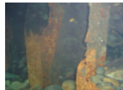
基礎矢板の損傷
